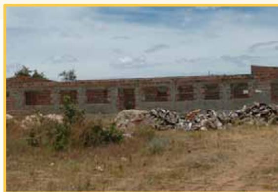
Construção do lar / internato na região da Humpata
