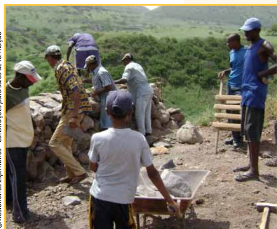
@Missionários Espiritanos - Construções para salas de formação
